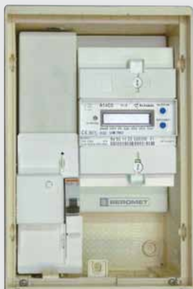
Coffret panneau enlevé
