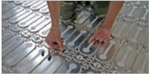
4. Verrouillez les plaques les unes aux autres avec les attaches, incluses dans le kit.
