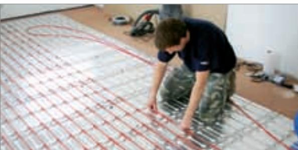
7. Vérifiez que les plaques ne soient pas recouvertes de copeaux de métal. Si c'est le cas, aspirez-les pour éviter tout dommage sur le câble. Installez le câble chauffant, en pressant délicatement le câble dans les rainures.
