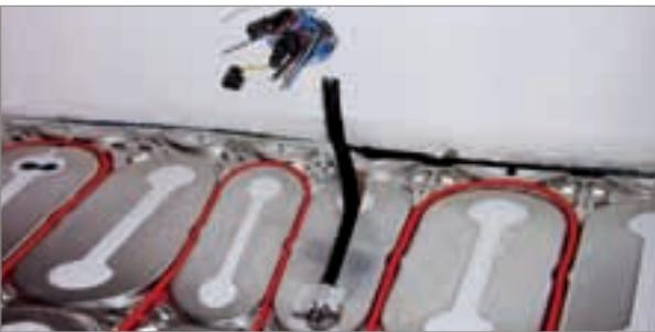
5. Faites une saignée dans la plaque isolante DEVicell Rénosol pour permettre à la sonde de dalle d'atteindre le sol. Puis placez-y le tuyau flexible du thermostat. Repoussez ensuite la liaison froide du câble du sol vers le mur, jusqu'à ce qu'elle atteigne le thermostat.
