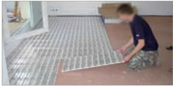
2. Disposez les plaques isolantes du système DEVicell Rénosol. *Fixer les plaques au sol en version carrelage.*
