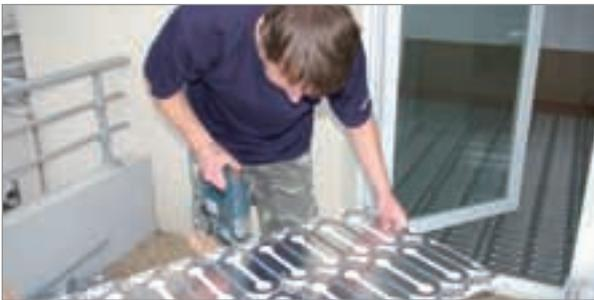
3. Les plaques DEVicell Rénosol doivent recouvrir l'entière surface de la pièce. Ajustez les plaques DEVicell Rénosol aux angles, en utilisant une disqueuse ou une scie électrique standard.
