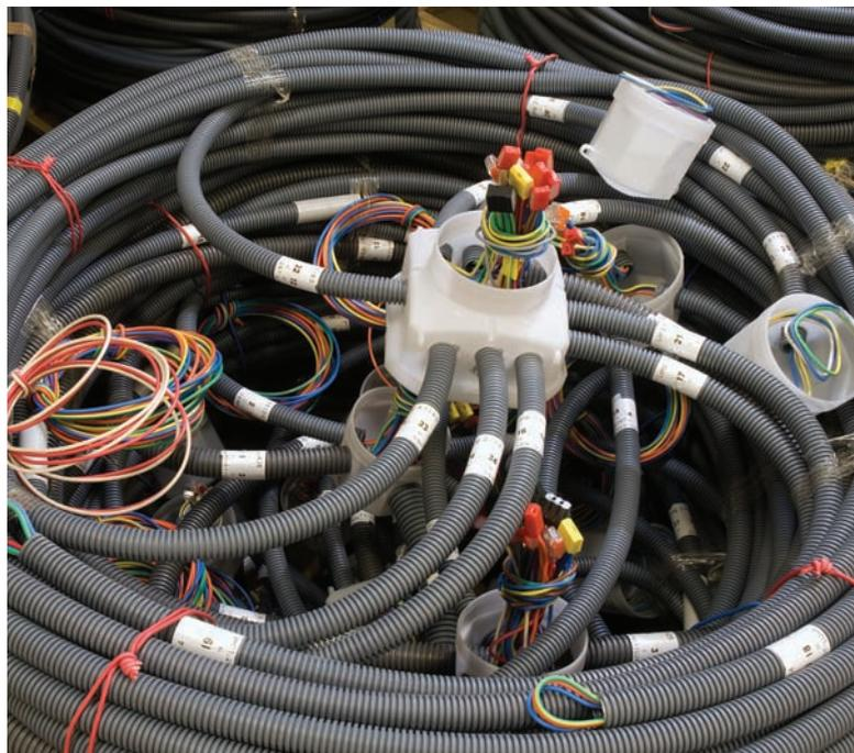
Pose facile et sans erreur : les pieuvres sont étiquetées (client, chantier, bâtiment, étage, n° de référence) ainsi que chaque bras, et chaque pieuvre est livrée avec un plan de pose réalisé sur AUTOCAD.
